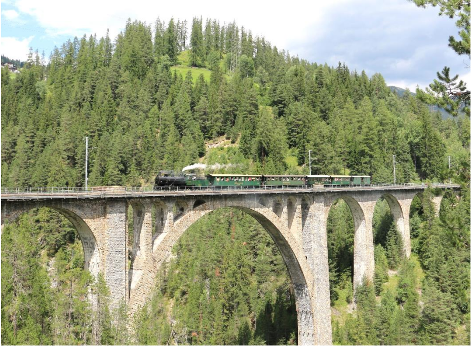
Dampfzug vom 07.08.21 auf dem Wiesner Viadukt (Bild: Stefan Wyss)
