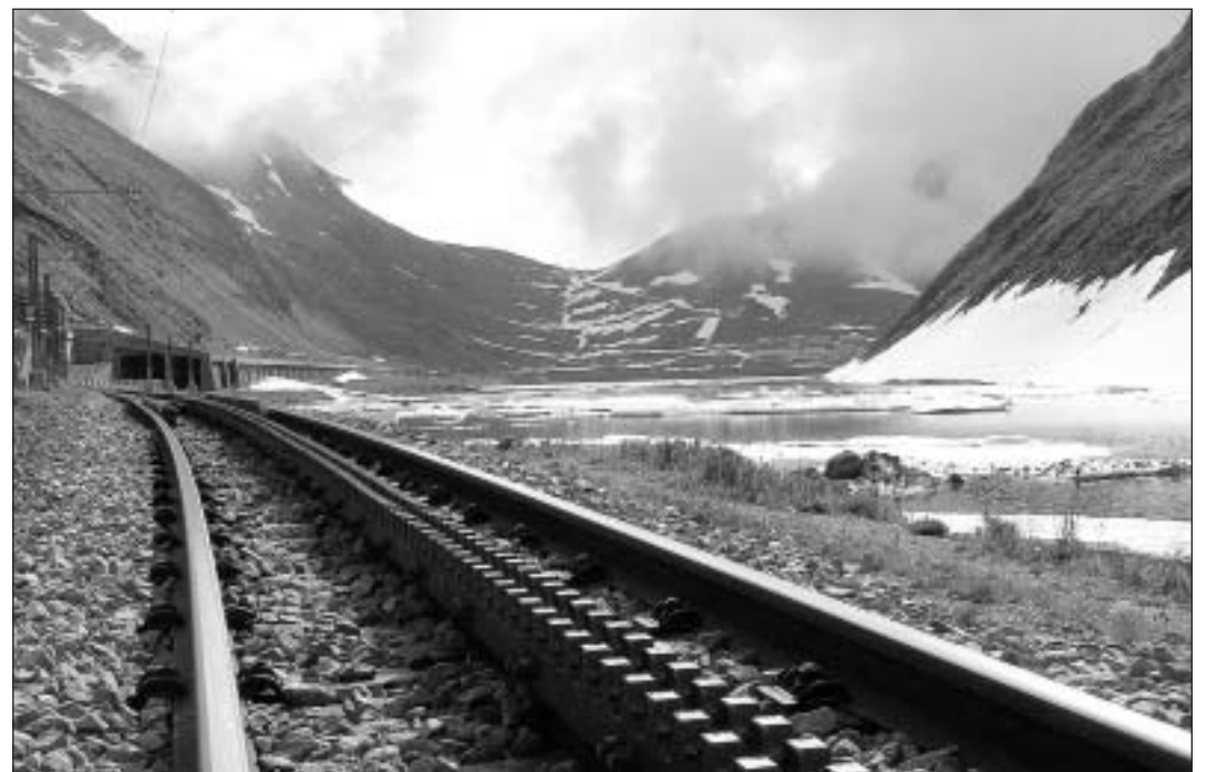
125 Promille Steigung: Um den höchsten Punkt der Strecke auf dem Oberalppass zu erreichen, ist ein Zahnstangensystem nötig.
